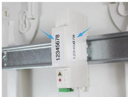
Poser les étiquettes d'identification sur le côté du boîtier et/ou sur la face avant.
